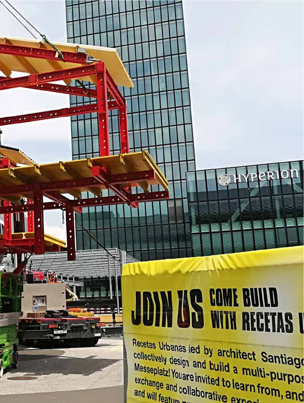
Proceso de construcción del proyecto Basilea. Art Basel, 2018.
