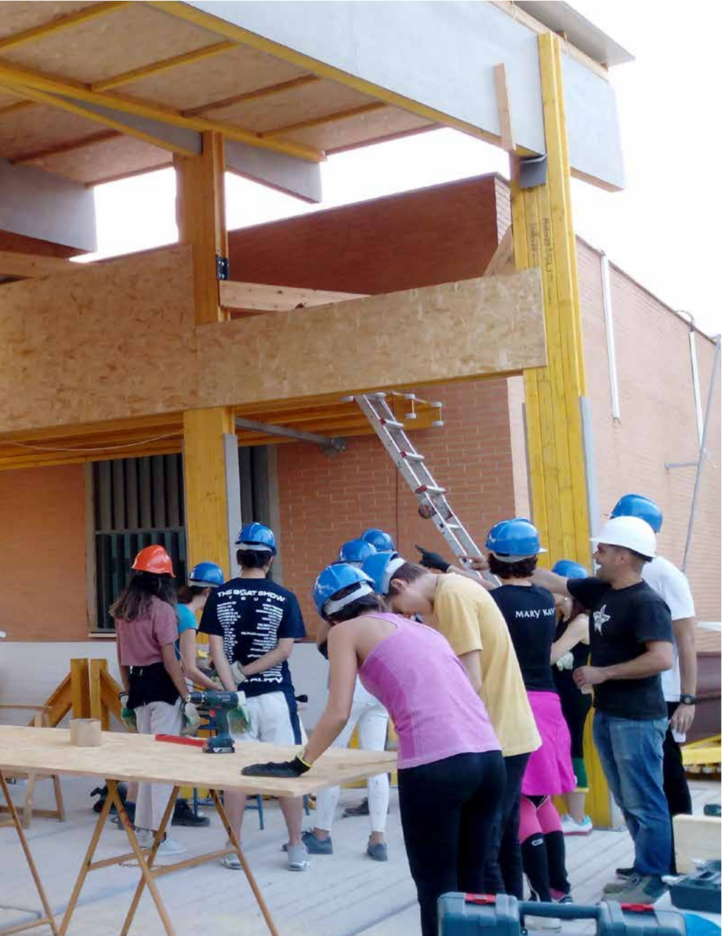
Proceso de construcción del Aula de Convivencia. Sevilla, 2016.
