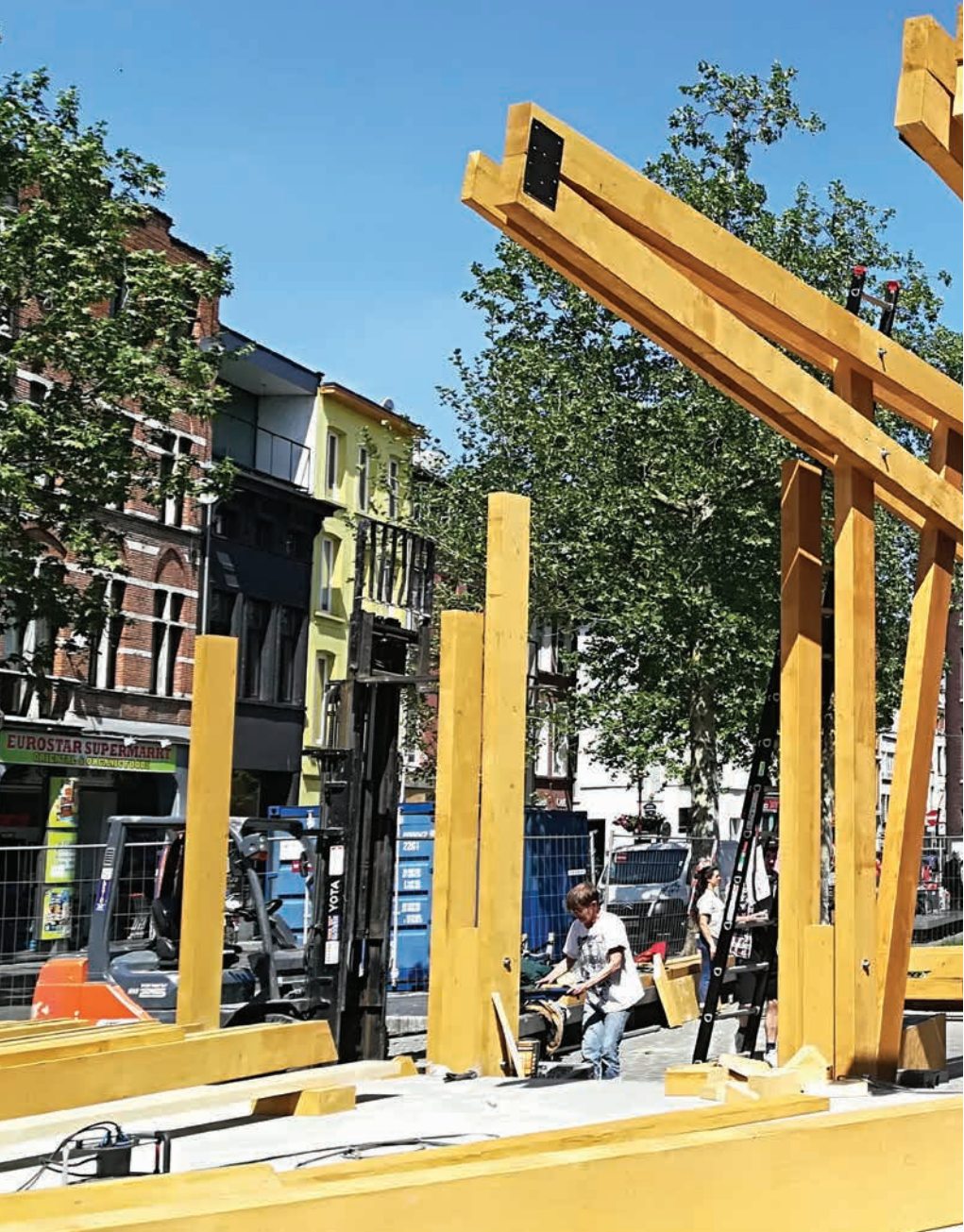
Proceso de construcción de la Montaña Verde . Amberes, 2018.
